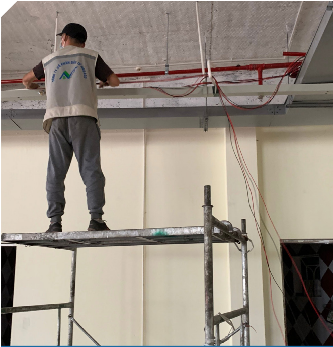
LẮP ĐẶT HỆ THỐNG MĂNG CÁP 51 NGỌC XUÂN
