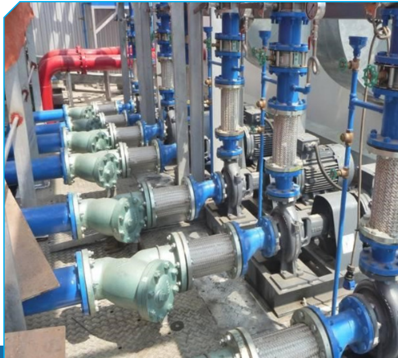
THI CÔNG HỆ THỐNG BƠM, CẤP THOÁT NƯỚC
