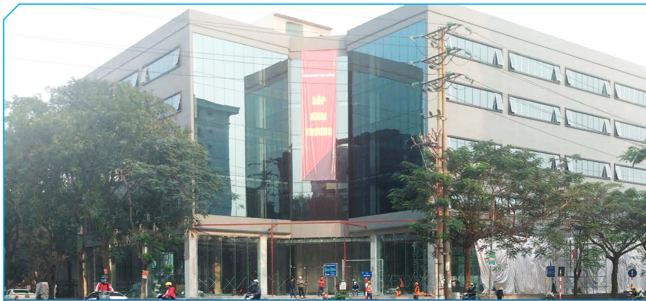
TÒA NHÀ DỊCH VỤ THƯƠNG MẠI SIÊU THỊ VÀ KHU VUI CHƠI GIẢI TRÍ
